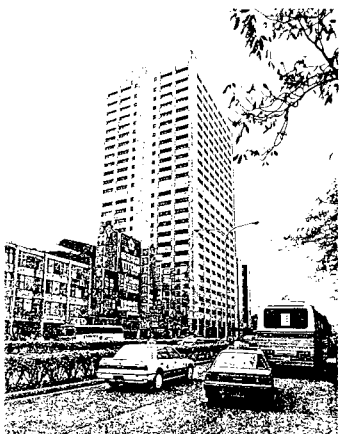
■ 高層建築的興起，對於環境的影響必須深思。 圖為台電大樓。
