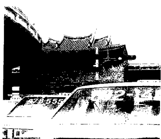
■ 都市歷史建築的另一窘迫。 圖為高架橋下的北門。
