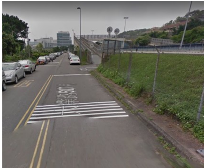
圖 2.3.1 跨越軌道之 U 型陸橋
