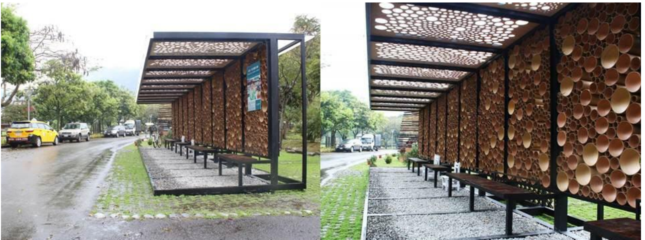
圖 50：候車亭，完工照片
