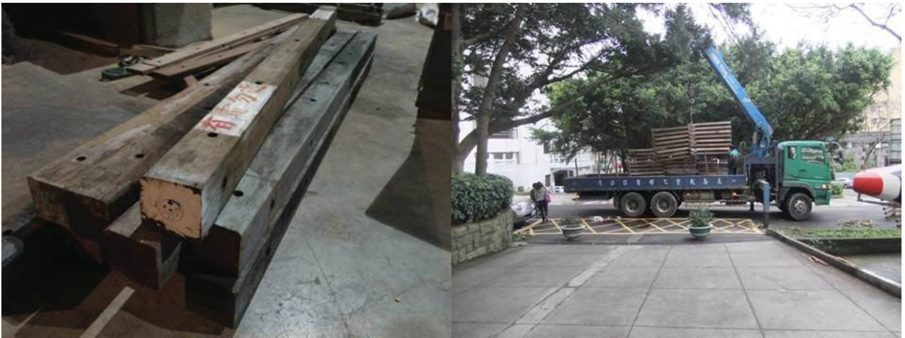
圖 8：展示亭 01：鳥踏，吊裝過程。
